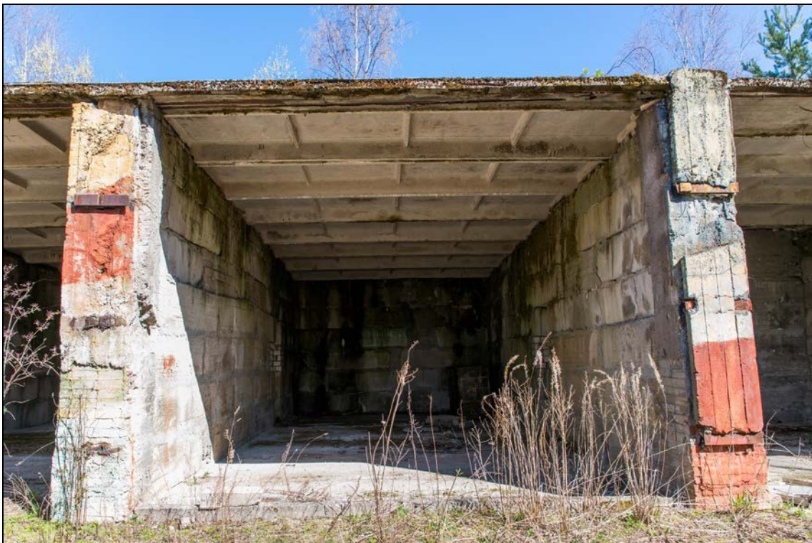
Foto 26 (1217). Lobi raketibaas. Angaar [3]. Laepaneelid on veel heas korras. Foto Mart Mõniste 24.04.2014.
