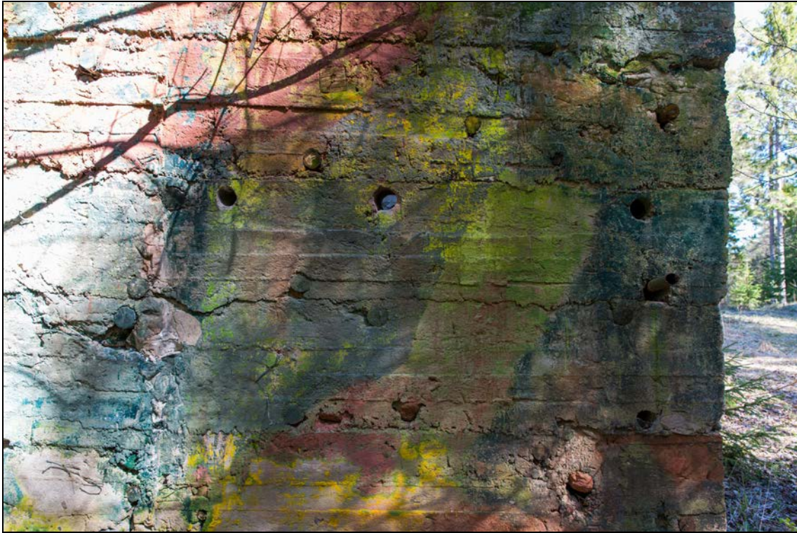
Foto 32 (1242). Lobi raketibaas. Angaar [3]. Betoonseina sisse on saalungite kooshoidmiseks pandud puujupid, mis kõdunedes jätavad seina augud. Foto Mart Mõniste 24.04.2014.
