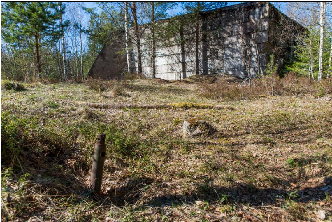
Foto 28 (1245). Lobi raketibaas. Angaar [3]. Massiivne ankur annab tunnistust, et angaar võis olla kaetud maskeerimisvõrguga? Foto Mart Mõniste 24.04.2014.
