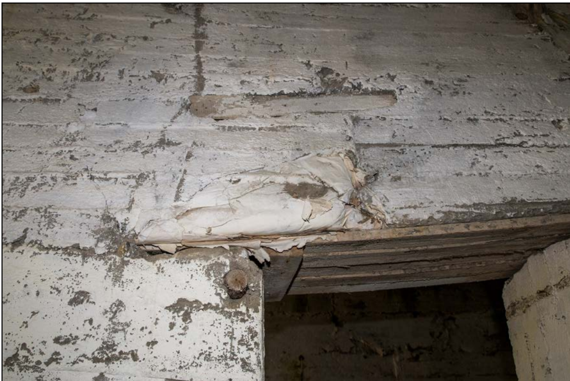
Foto 18 (1196). Lobi raketibaas. Angaar [2]. ... aga siiski - betooni sisse asetatud tervet tsemendikotti näeb esmakordselt!
